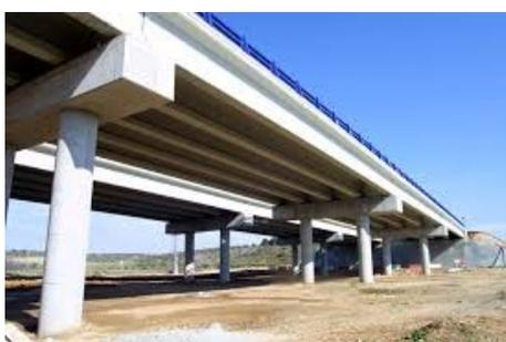
**Pont en béton précontraint**
