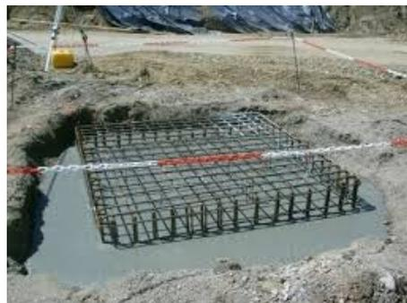
Béton structurel : 350 kg/m<sup>3</sup> de ciment.
