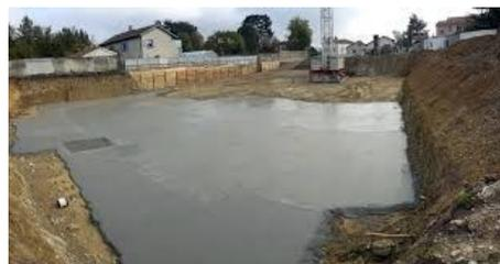
Gros béton (fondations) : 250 kg/m<sup>3</sup> de ciment ;
