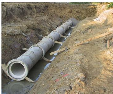
*Tuyauteries en béton non armé*
