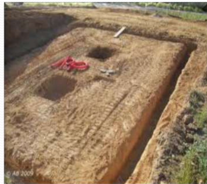
Fouilles en puits
