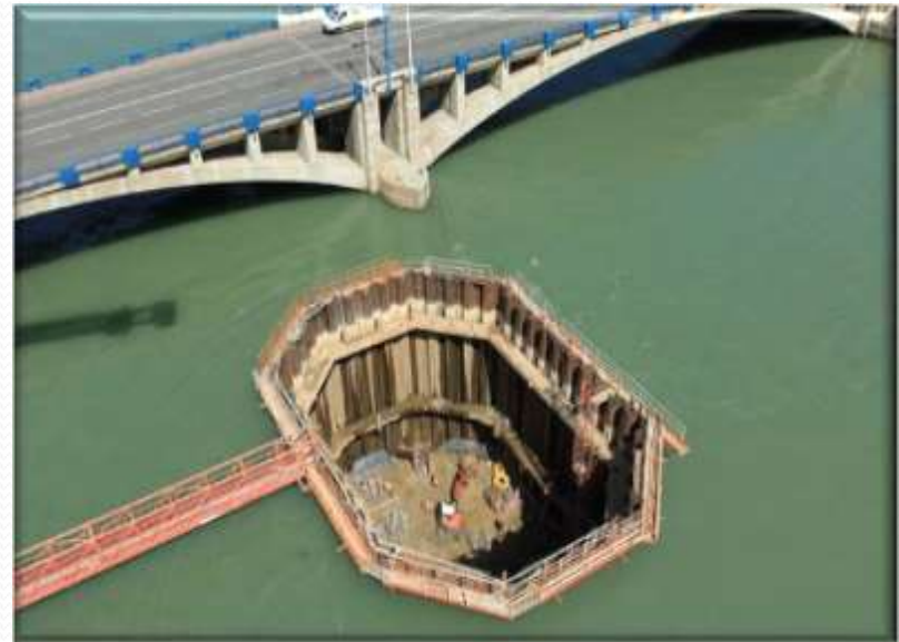
L'utilisation des palplanches
