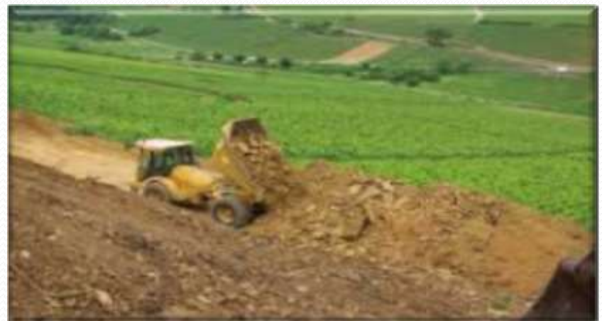
Terrassement en remblai
