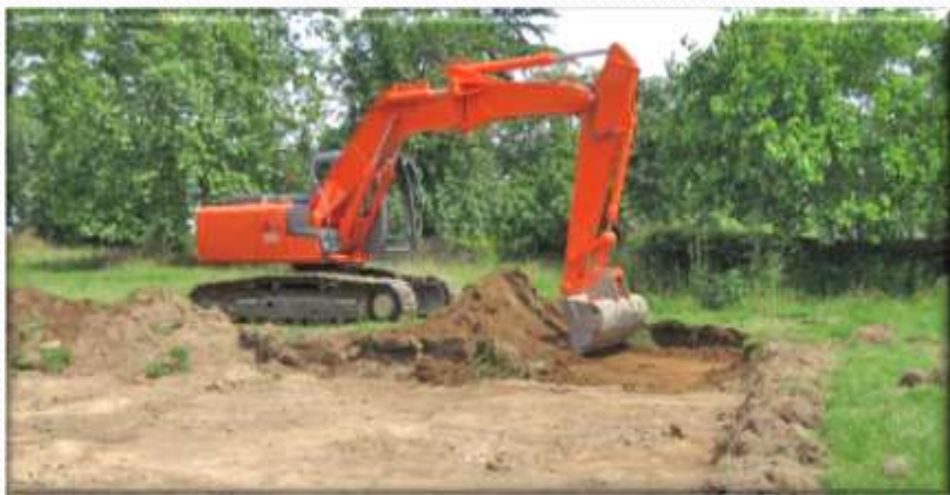
Terrassement en déblai
