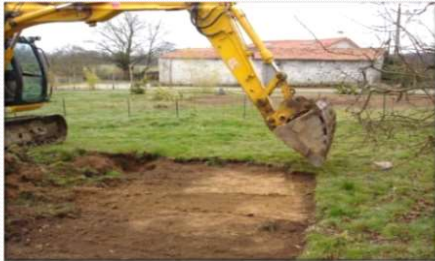
Le décapage de la terre végétale
