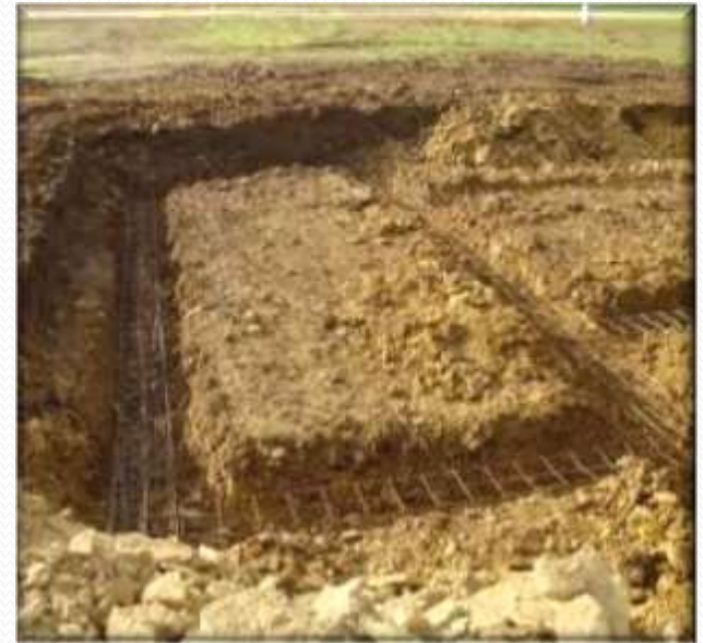
Les fouilles en rigole
