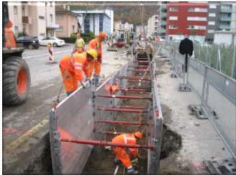
Blindage des fouilles
