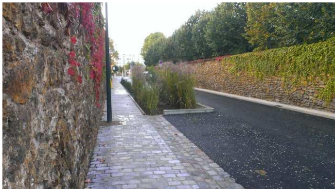
Fig. n°9 photo ouvrages végétalisés
