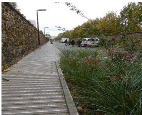
Coupe et photo d'un massif planté décaissé avec continuité piétonne en platelage bois
