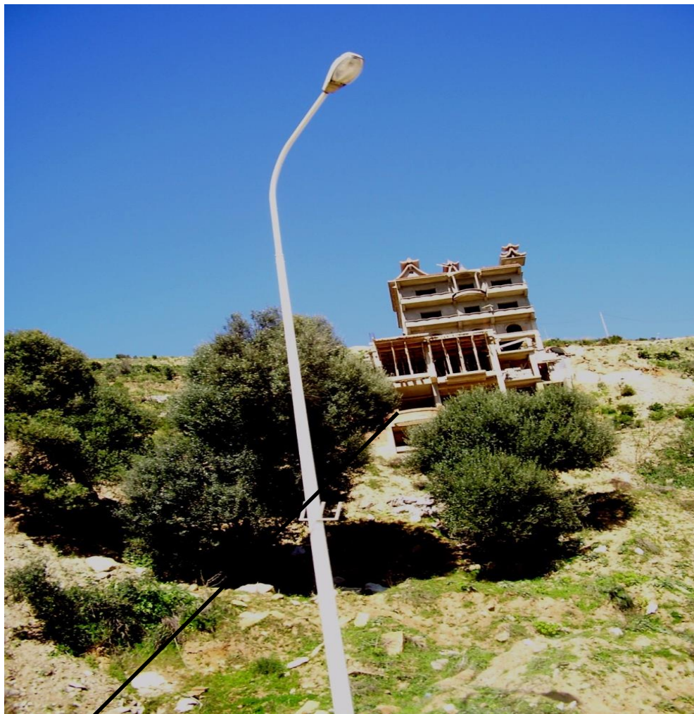
photo. n°7 Effondrement d'une maison suite à un glissement de terrain (Algérie)
