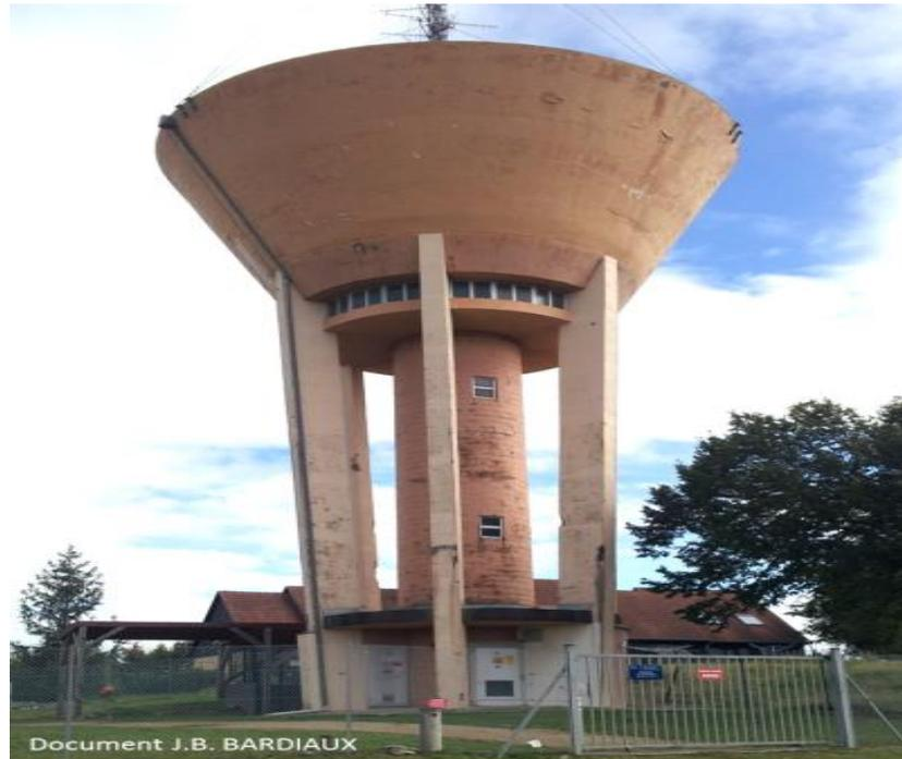
Fig.9 réservoir type béton surélevé
