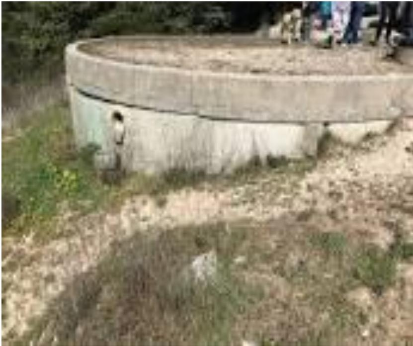
Fig.8 réservoir type béton enterré
