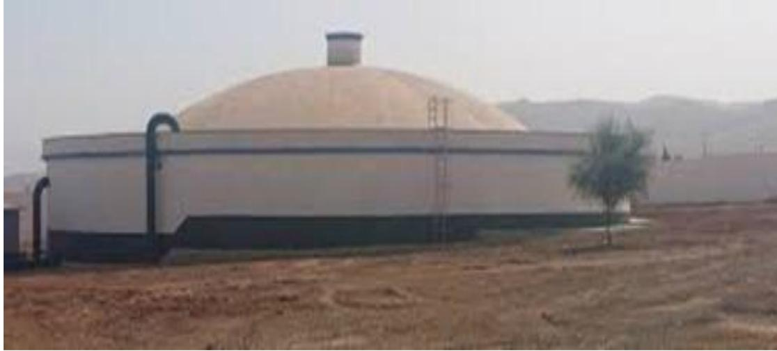
Fig.7 réservoir type béton semi enterré
