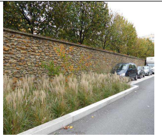
Fig. Coupe et photo d'une noe de collecte-infiltration avec fosse d'arbre associée
